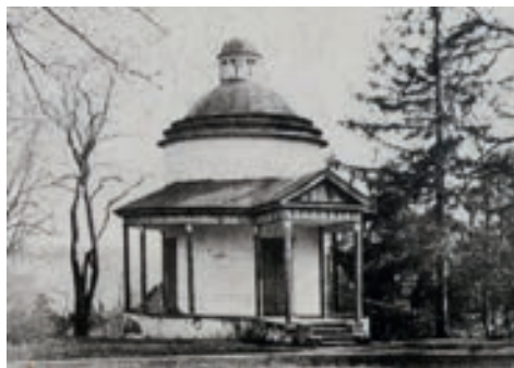
Zaniklý pavilon tzv. Rotunda u hradu Bítov. Informační panel, 1830.
