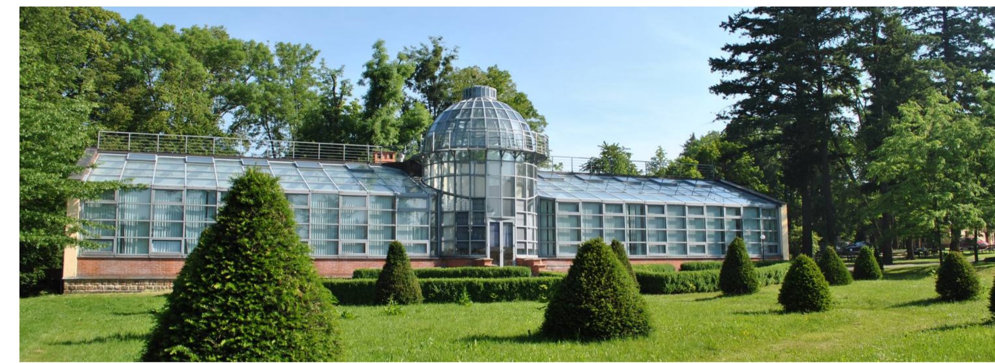
Původní výstavná konstrukce historického skleníku v Dolních Životicích byla nahrazena soudobou konstrukcí postrádající zdobné detaily.
