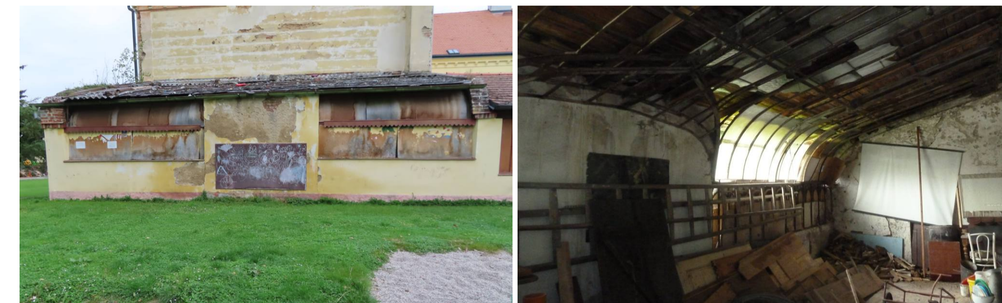
Kovová konstrukce zimní zahrady zámku Osvračín se dochovala pod utilitární střechou.
