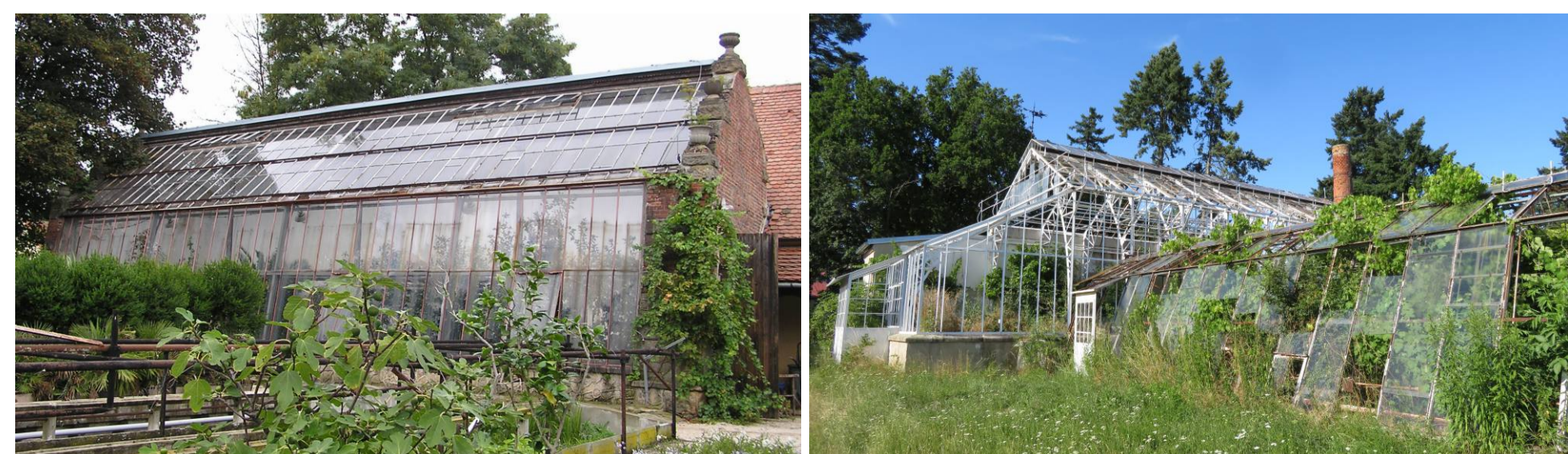
Skleník v zámeckém zahradnictví v Buchlovicích má v konstrukci významný podíl zděných částí, v Jevišovicích se dochovala celokovová konstrukce.
