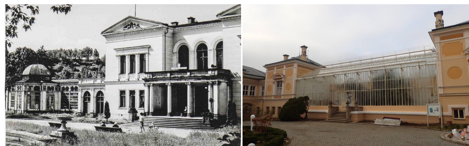
Bohatě členěná konstrukce skleníku u Leitenbergovy vily se nedochovala, narozdíl od zimní zahrady integrované do zámecké budovy ve Světle nad Sázavou, která prošla kompletní obnovou.
